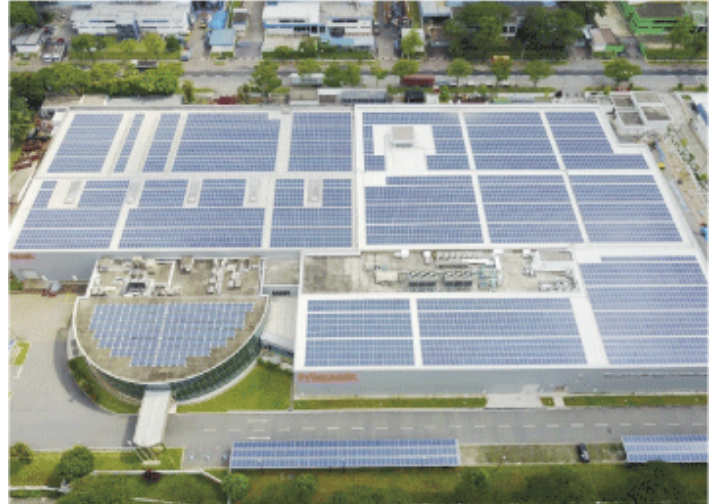
屋上に太陽光発電システムを設置したシンガポール工場＝シンガポール西部 (同社提供)
